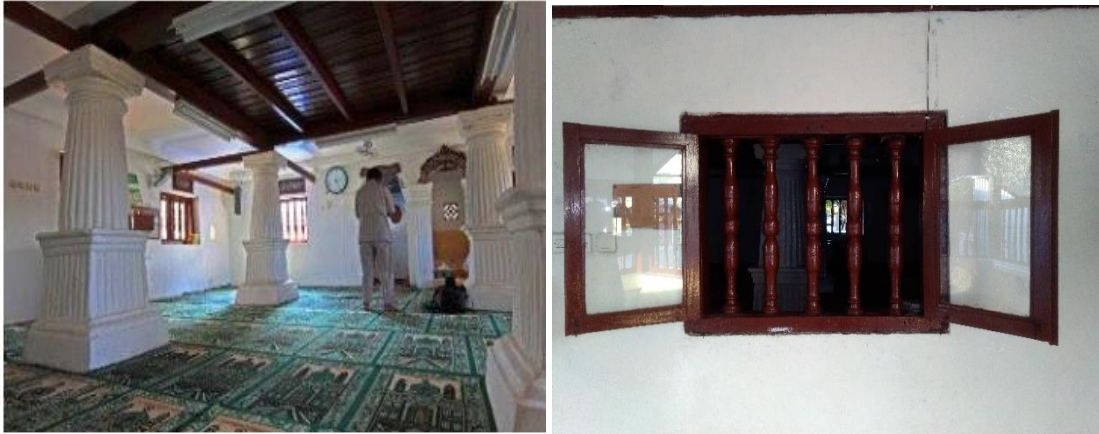
Gambar 2. Empat pilar dan jendela pada Masjid Al-Alam
